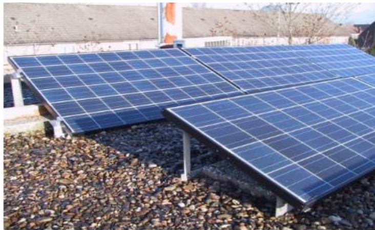
Figura 10. Ejemplo de problema de superposición entre filas de módulos
