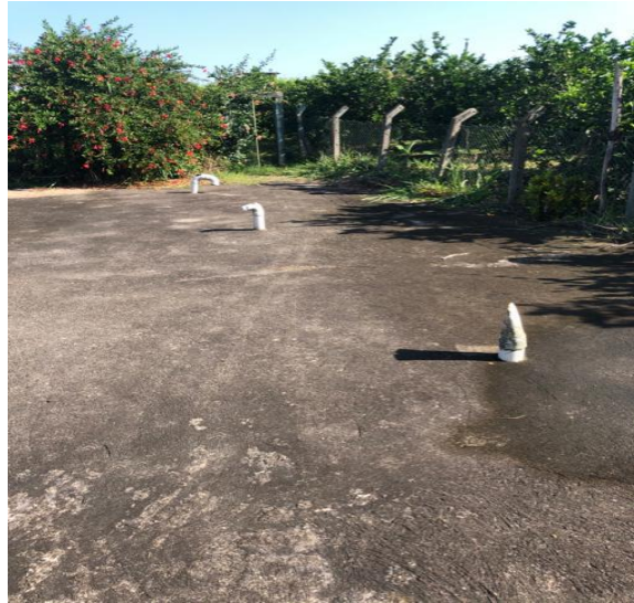
Ilustración 15. Reservorio secundario del distrito de riego actual
