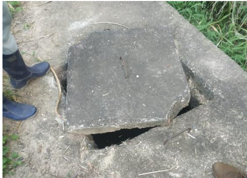
Ilustración 11. Desarenador de la captación principal del distrito de riego
