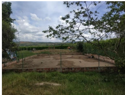
Ilustración 14. Reservorio de 1080 m 3 del distrito de riego actual
