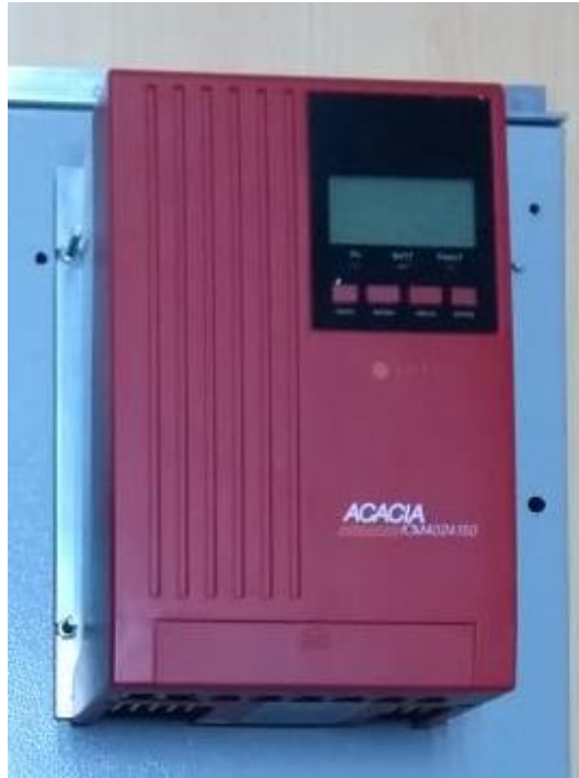
Figura 13. Controlador de carga MPPT Acacia ICM4024150.
