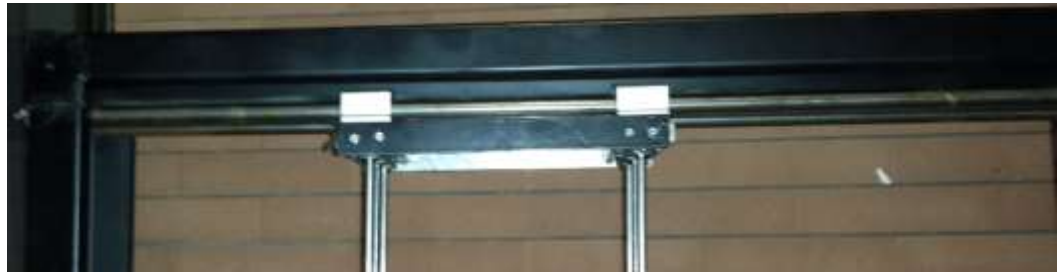
Figura 65. Comprobación de desplazamiento [Autores]
