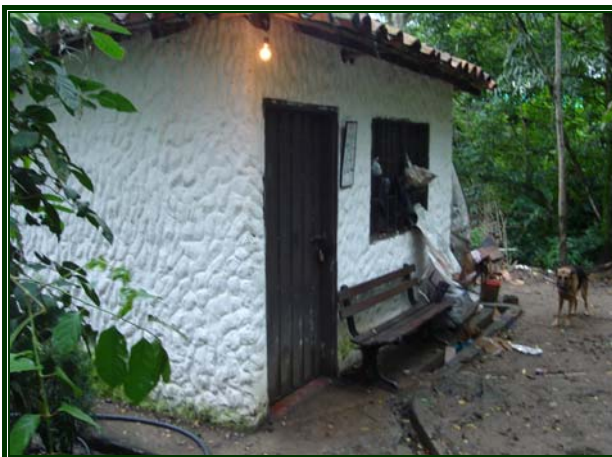
Figura 13. Casa del Personal del Parque El Gallineral
