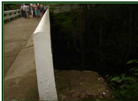
Figura 54. Abertura del Puente del Parque El Gallineral
