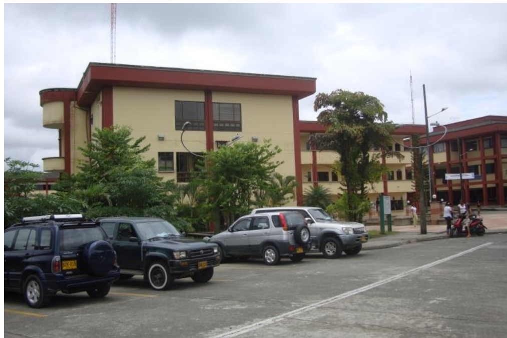
BLOQUE ADMINISTRATIVO (CUARTO DE COMUNICACIONES CENTRAL)
