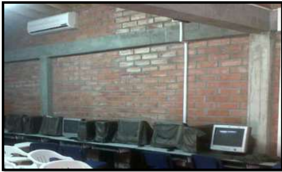
Figura 34. Sala de sistemas 1 - TECOC
