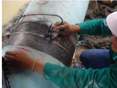
Fig. 2. SOLDADURA APLICADA EN SECCIÓN DE TUBERÍA.
