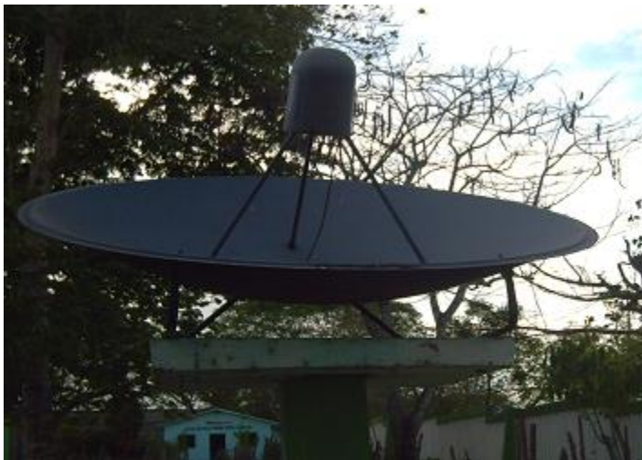
Anexo 15. Antena de Compartel de la Institución Educativa del corregimiento del Retiro.
