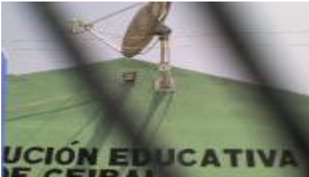
Anexo 7. Antena de Compartel de la Institución Educativa del corregimiento del Ceibal.
