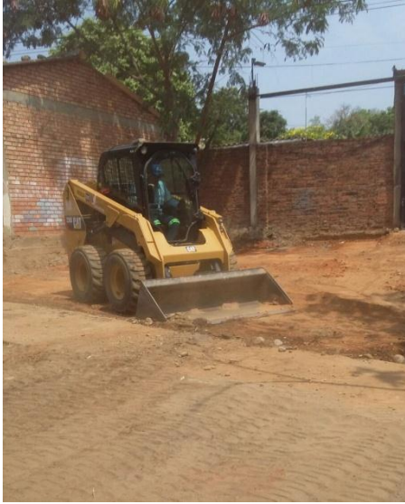
Fotografía 11. Fuente. D.I Fecha: febrero 2016. Maquinaria para explanación del terreno. En apoyo aseo urbano
