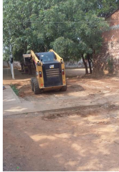
Fotografía 12. Fuente. D.I Fecha: febrero 2016. Explanación del terreno donde funciona las eras de hortalizas actualmente.
