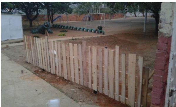
Fotografía 32. Fuente. D.I Fotografía que evidencia el proceso de construcción y adecuación.
