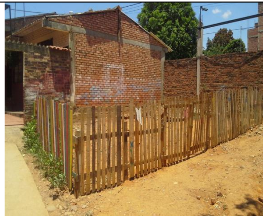
Fotografía 39. Fuente. D.I Cambiando espacios en mejores ambientes de aprendizaje.
