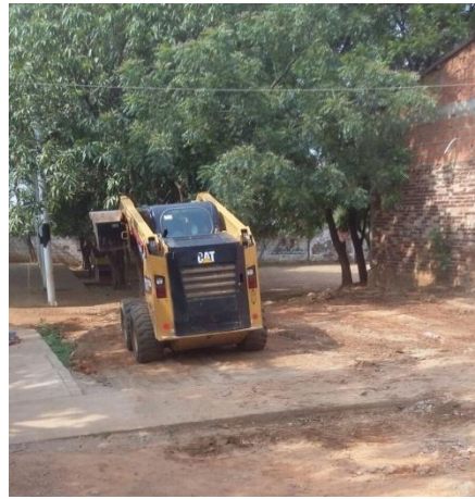
Fotografía 31. Fuente. D.I Fotografía durante la intervención de explanación.
