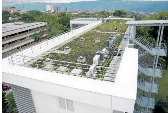
Edificio verde UIS
