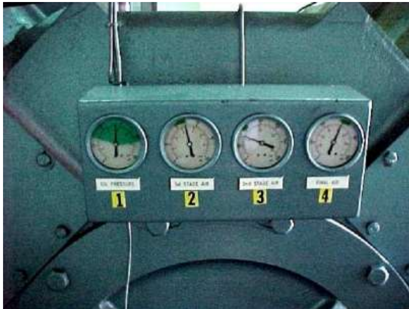
Foto 5. Marcación de indicadores de presión, temperatura, flujo y velocidad. Fuente: Varta S.A.
