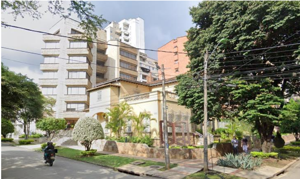
Figura 8. Vista Frontal del Edificio La Casona
