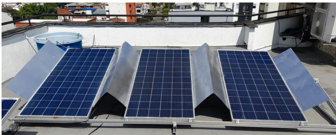
Figura 18. Instalación de los Reflectores en los Paneles Solares
