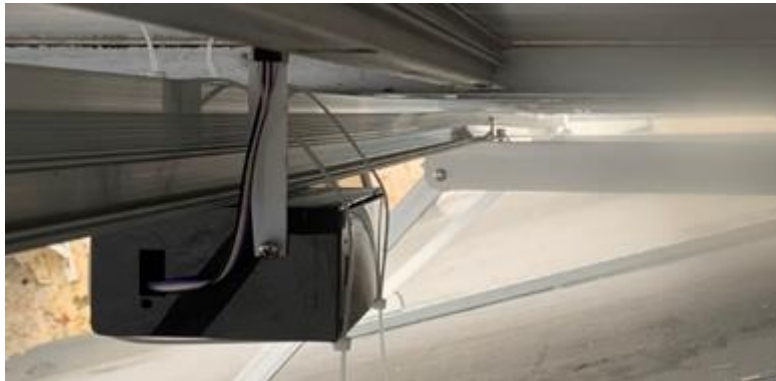
Figura 20. Instalación de Cajas de Arduino
