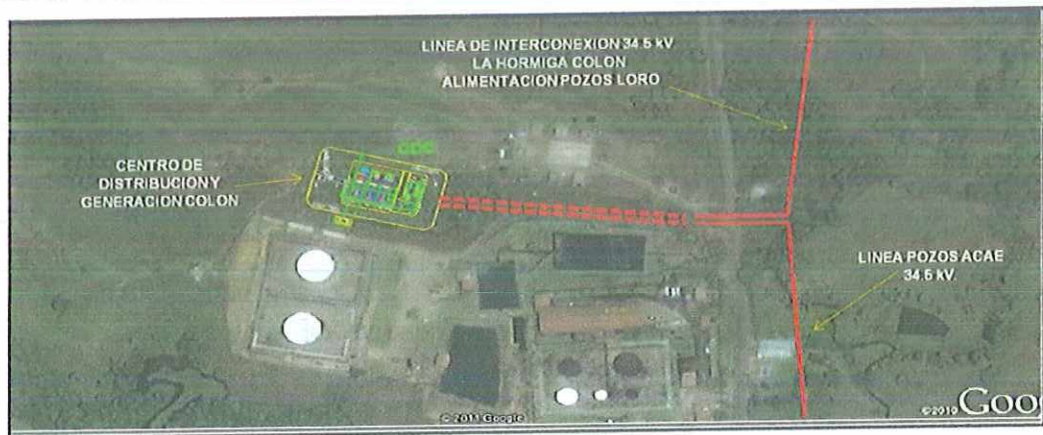
Figura 4. Vista aérea Instalaciones de la batería Colón
