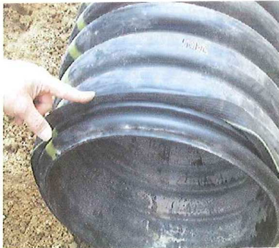
Fotografía 6 : Sistema de unión
