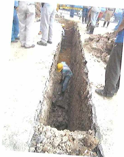
Fotografía 5. Ancho de Zanja
