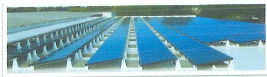
Figura 27. Vista general de sistemas instalados con soporte en fibra de vidrio.
