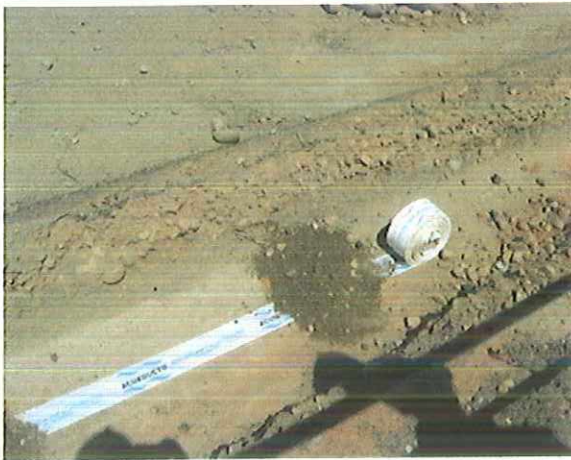
F.7. Cinta para indicar existencia de tubería
