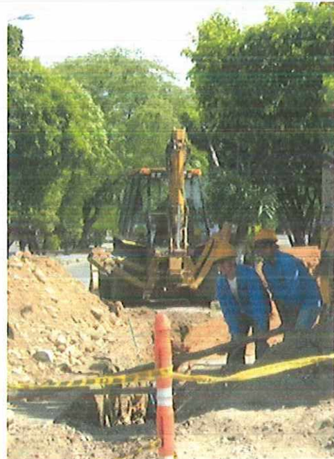
F.8. Zanja para instalación de tubería
