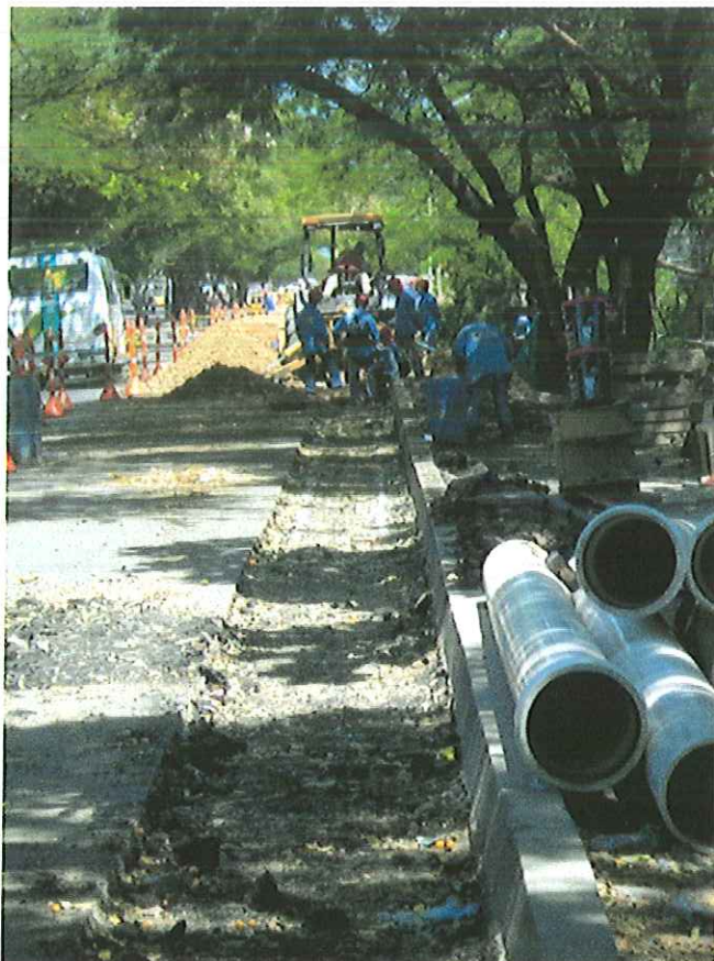
F.2 Zanja para re parchar y tubería de 24" PVC
