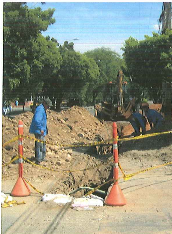
F.4 Zanja abierta línea de 24 "
