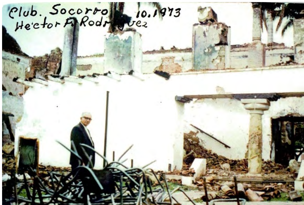
Interior del Club del Socorro después del incendio de 1973 (Archivo fotográfico de Héctor Rodríguez – Eduardo Rodríguez).
