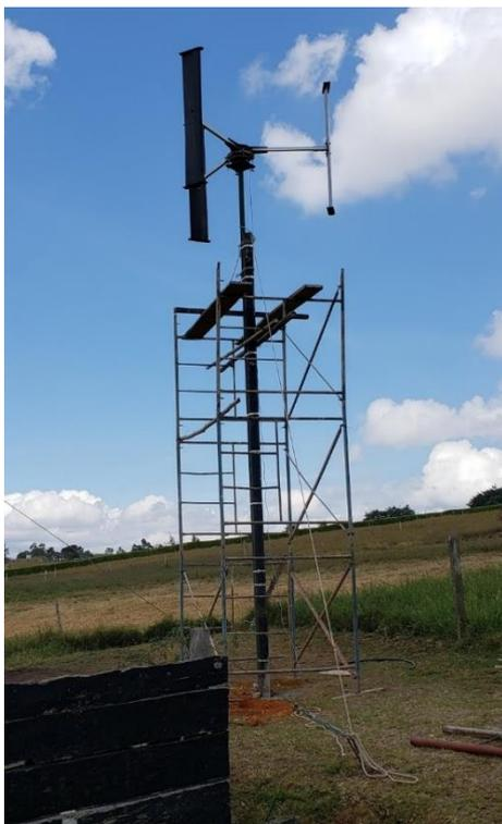
**Figura 77.** Montaje en base cimentada <sup>[AUTOR]</sup>
