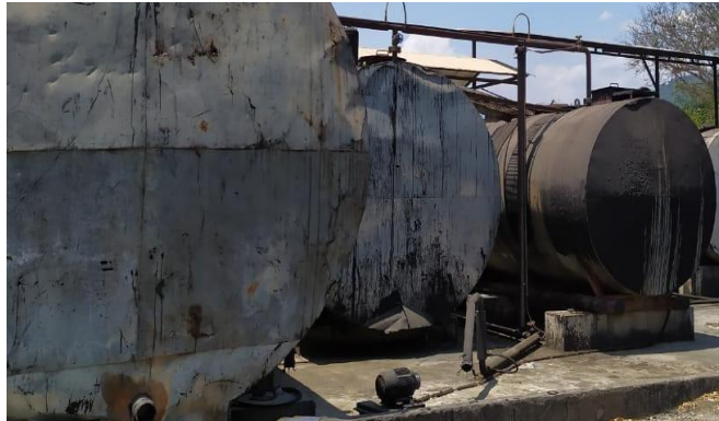
Figura 15. Bomba de descarga.
