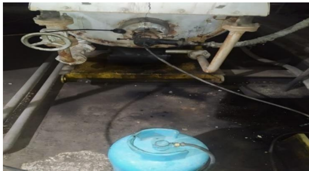
Figura 21. Electrodo de ignición improvisado.
