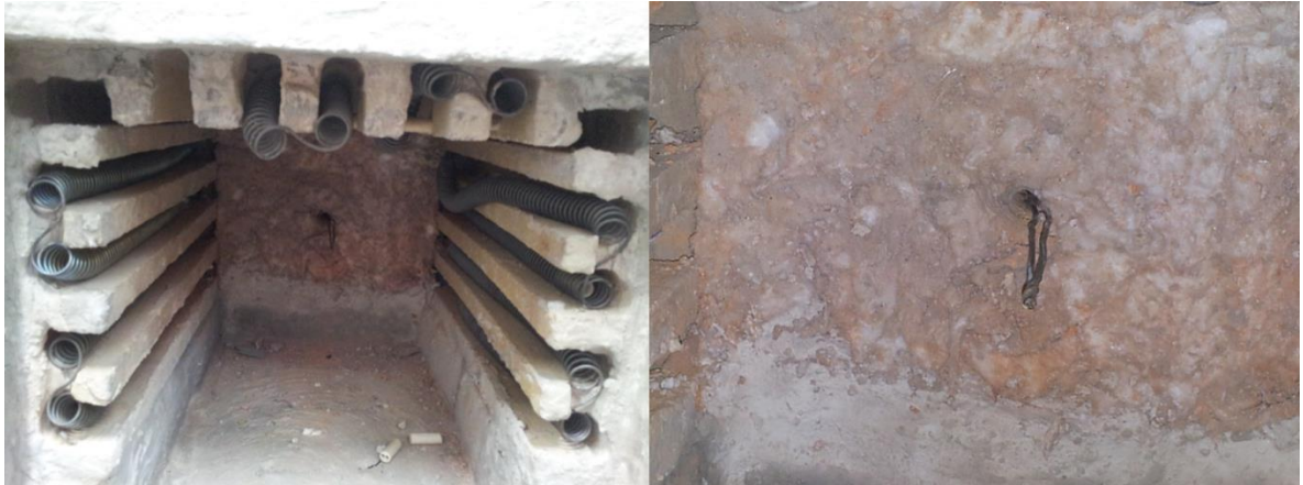
Ilustración 156 Cavity interior del horno
