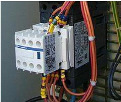
Figura 9 - Contactor de CA para la aplicación de bombeo
