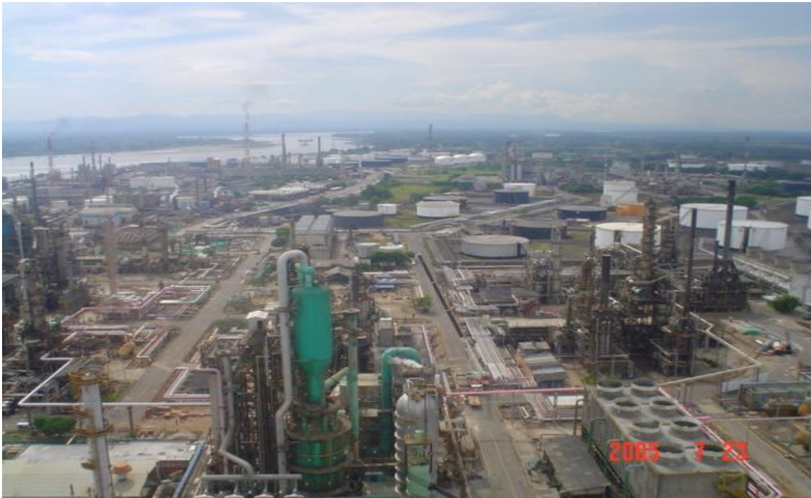
Figura 10. Refinería de Barrancabermeja, Responsabilidad Integral (DRI) – Ecopetrol S.A.
