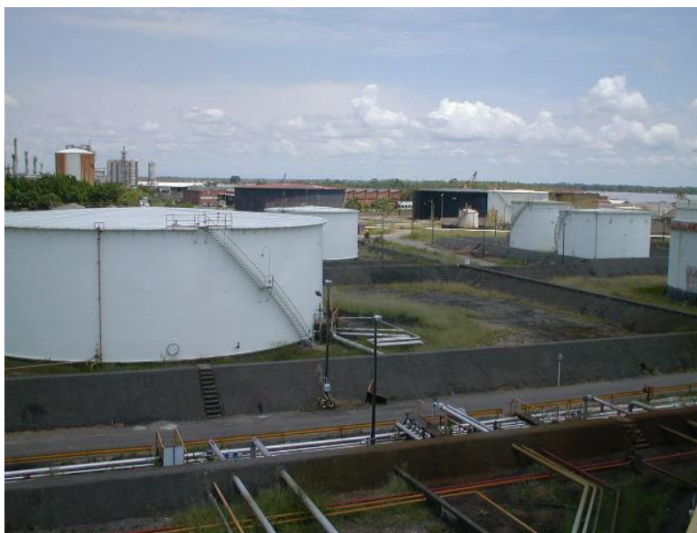
Figura 23. Zona de tanques GRB, del autor
