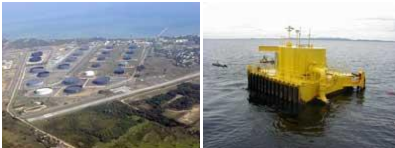
Figura 5. Vista aérea terminal Coveñas, Intranet de Ecopetrol S.A.
