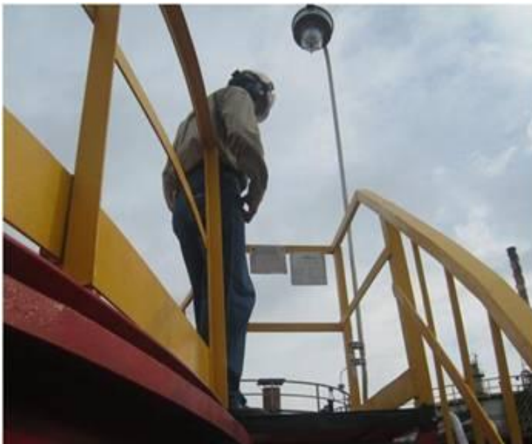
Instalación de tablilla de aforo y pruebas de telemetría
