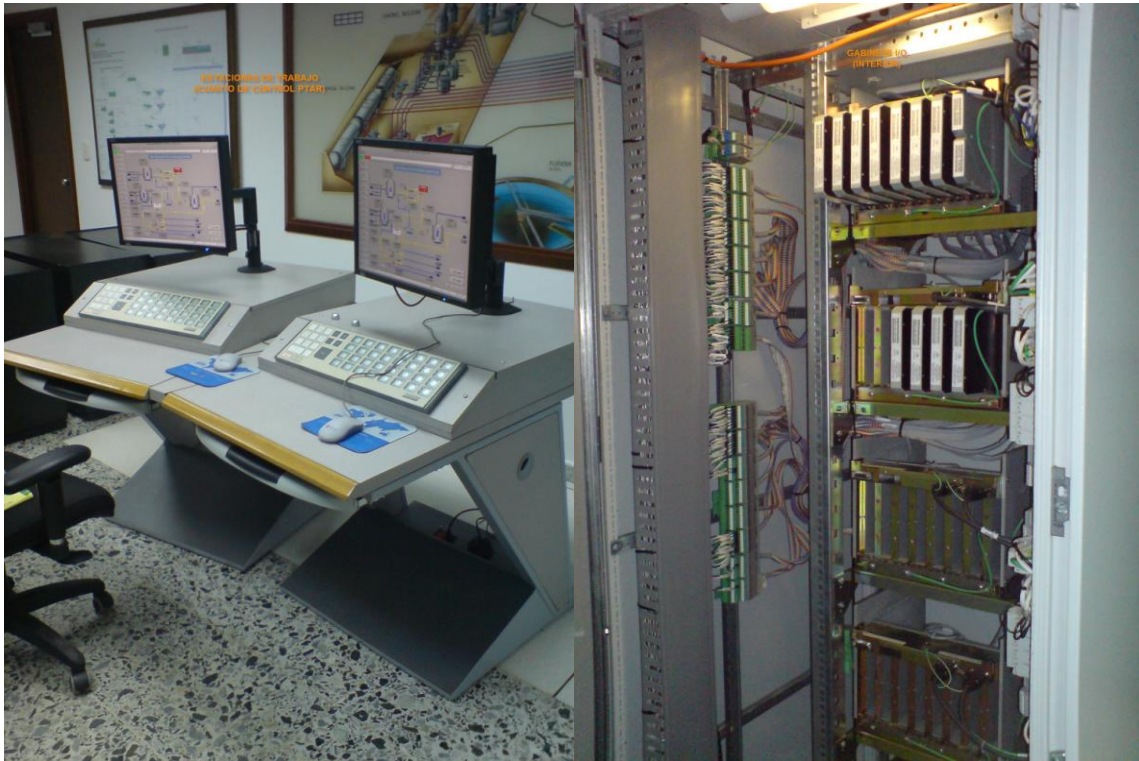
Figura 58. Estaciones de trabajo y Gabinete I/A (Cuarto de control PTAR), del autor
