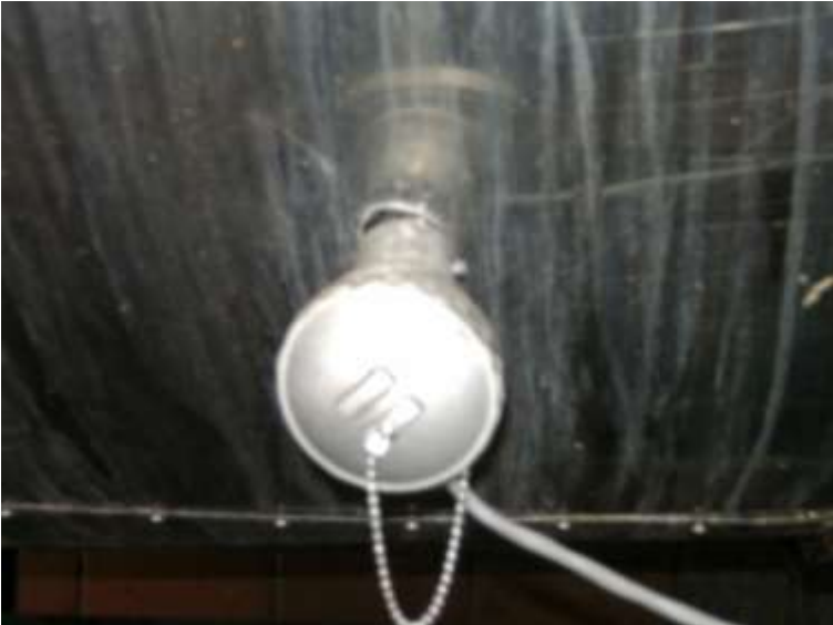
Fotografía 3. Instrumentación de Temperatura.
