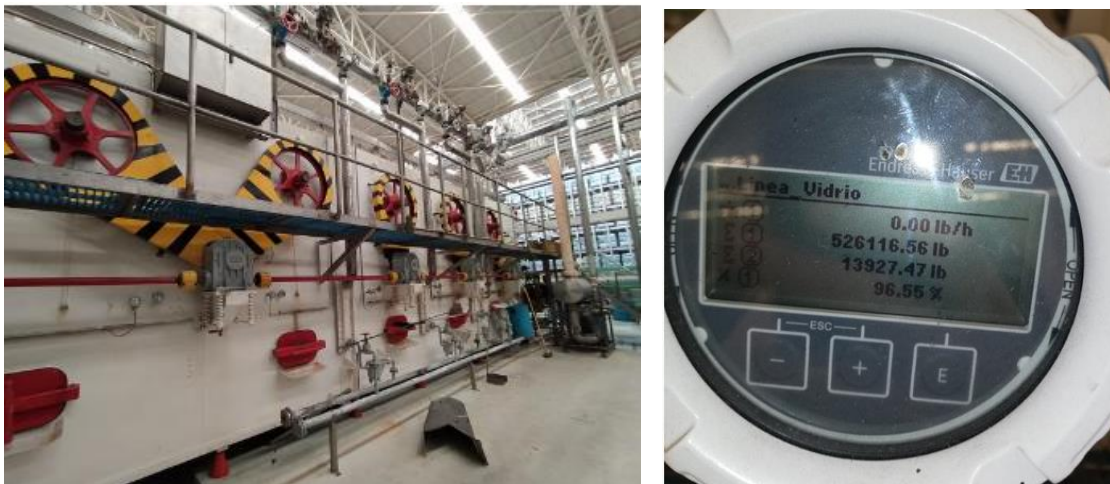
Ilustración 33. Consumo de vapor de la lavadora de botellas
