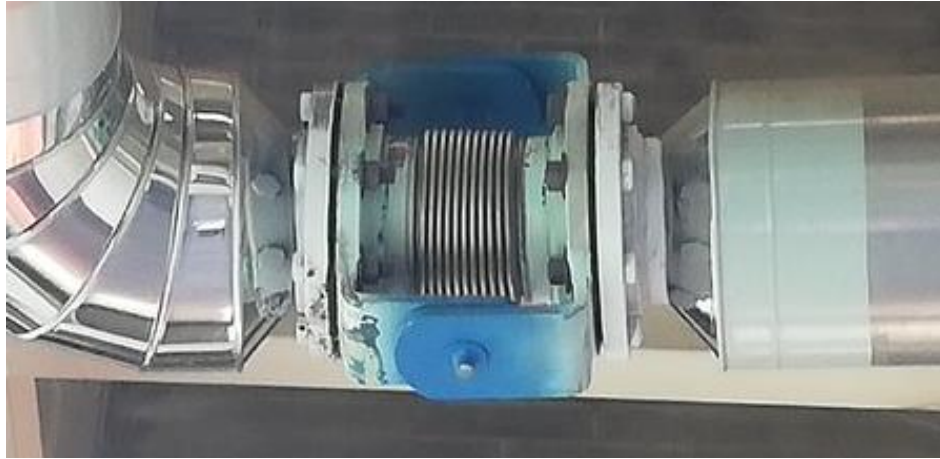
Ilustración 17. Junta tipo acordeón en la planta de Gaseosas Hipinto S.A.S.
