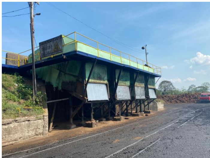
Figura 8. Tolva y zona almacenamiento en piso de materia prima Fuente: El autor
