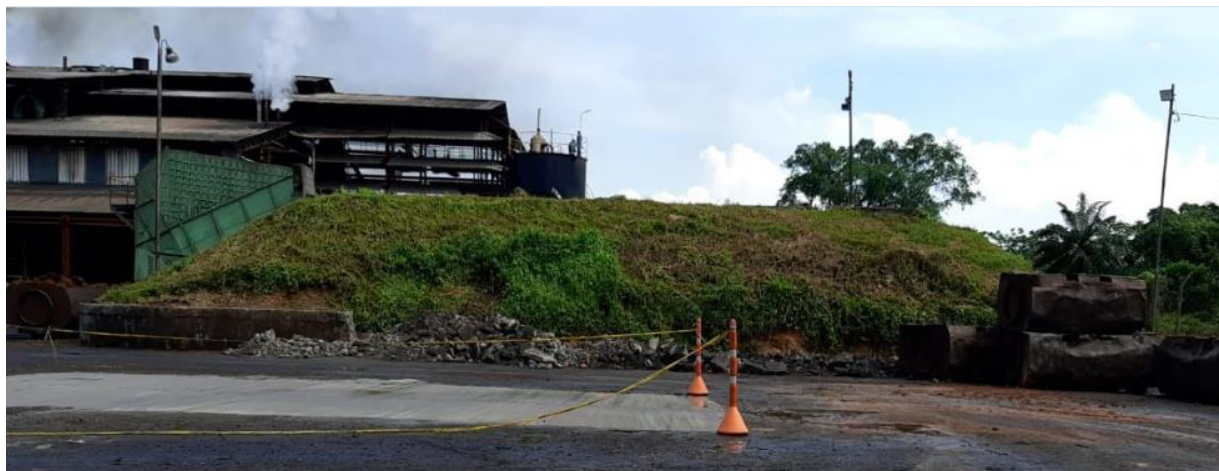
Figura 43. Vista frontal del lote para instalación de nueva tolva inclinada
