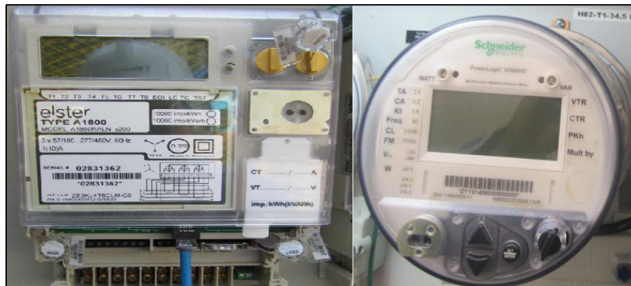
Fuente: Registros fotográficos de una S/E de un RF.
