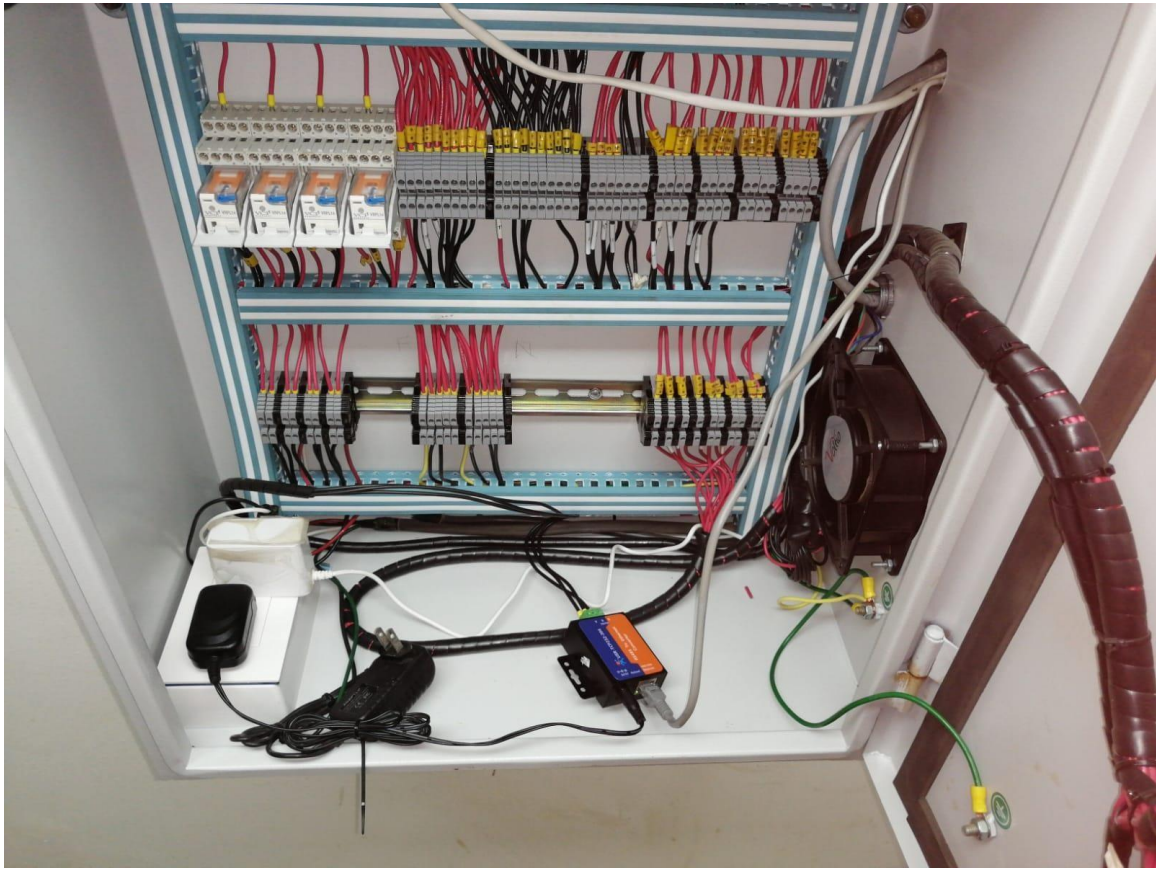
Figura 42. Prueba de Comunicación del Analizador Easylogic con el móduloUSR-TCP232 FUENTE: Autor.
