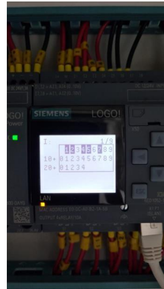
Figura 48. Verificación entrada digital 7 en el PLC que indica que está activa, lo que debe activar el sistema de alarmas. FUENTE: Autor
