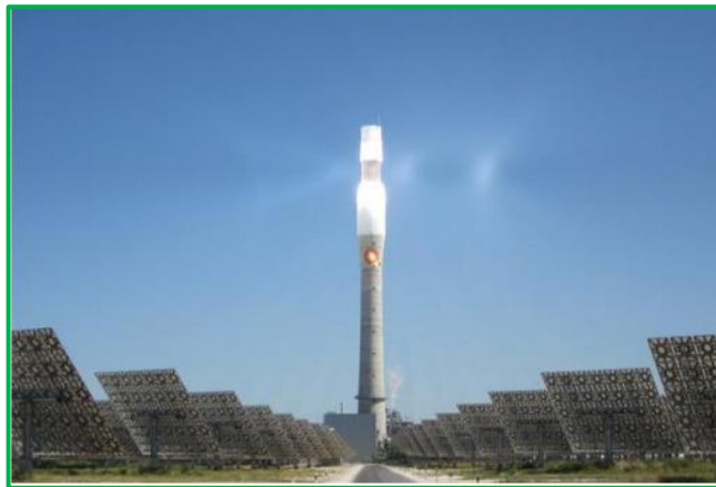
Figura 22. Receptor cilíndrico vertical de la central Gemasolar.
