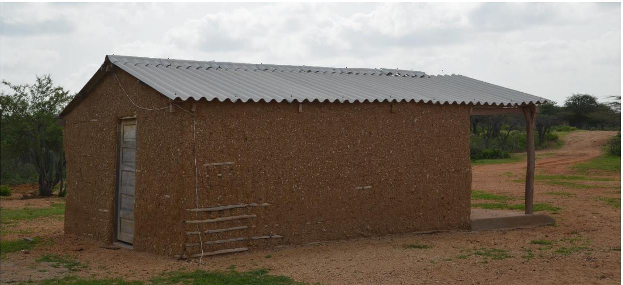
*Figura 15. Vivienda construida con barro, cemento y tejas de eternit*
