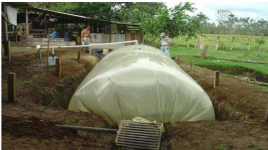
FIGURA 2. Biodigestor en bolsa doble de polietileno de bajo costo, modelo Taiwán, recién instalado (aún sin techo, ni cerca periférica), operando en una finca familiar.
