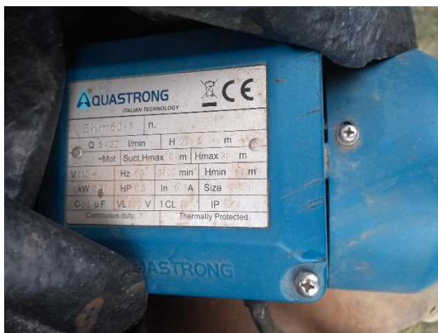
Figura 58. Electrobomba 110V/60Hz/0,5HP ubicada en la vereda Las Flores/Santa Bárbara, municipio de Hato Corozal – Casanare.
