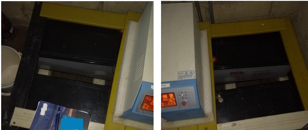
Figura 55. Sistema de almacenamiento del generador fotovoltaico.
