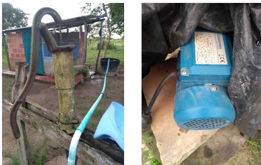
Figura 29. Cambio de extracción manual de agua a electrobomba.
