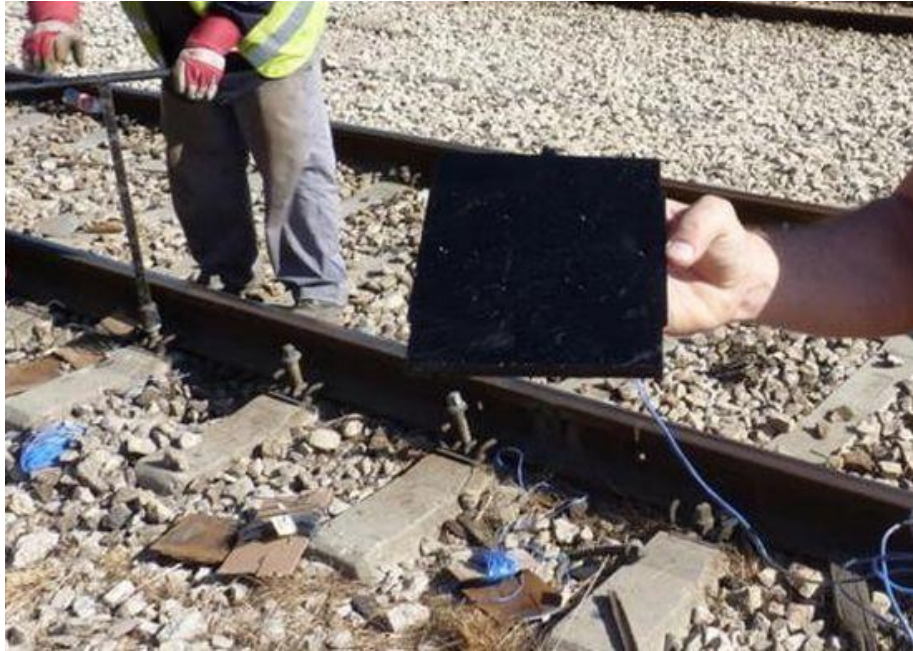
Figura 17. Instalación de dispositivos de Innowattech en vías de ferrocarril.
