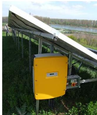
**Figura 12. Inversor instalado en un arreglo fotovoltaico**
