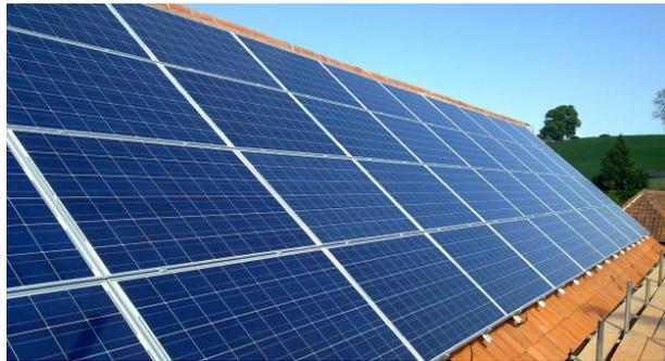
**Figura 39. Paneles solares fotovoltaicos montados sobre un techo inclinado de teja.**
