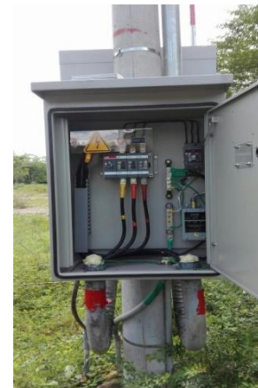
Figura 6. Caja de paso y caja de corte. [Autor].
