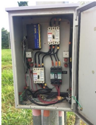
Figura 6. Caja de paso y caja de corte. [Autor].
