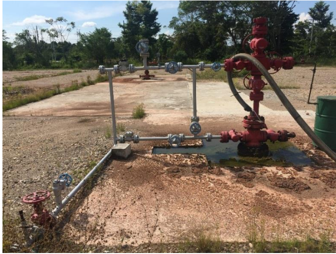
Figura 12. Unidad de bombeo electrosumergible. [Autor].
