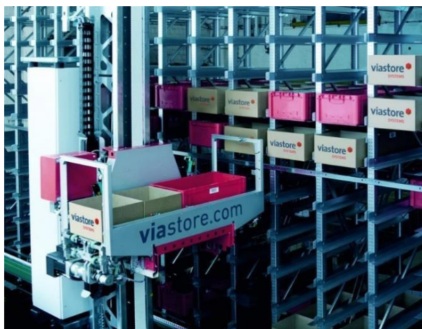
Figura 18. Transelevador de múltiple fondo V.S. https://www.viastore.com/systems/es
