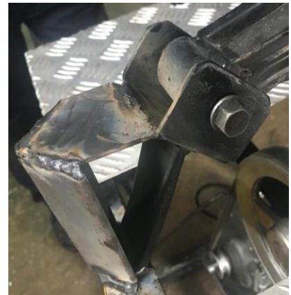
Imagen tomada en el proceso de construcción.
