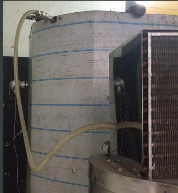
Manguera conectada entre el tanque fermentador y el Chiller para que recircule desde el tanque hasta el chiller.
