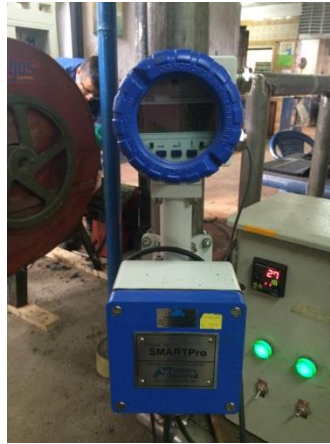
Figura 7-11. Transmisor de pH.
