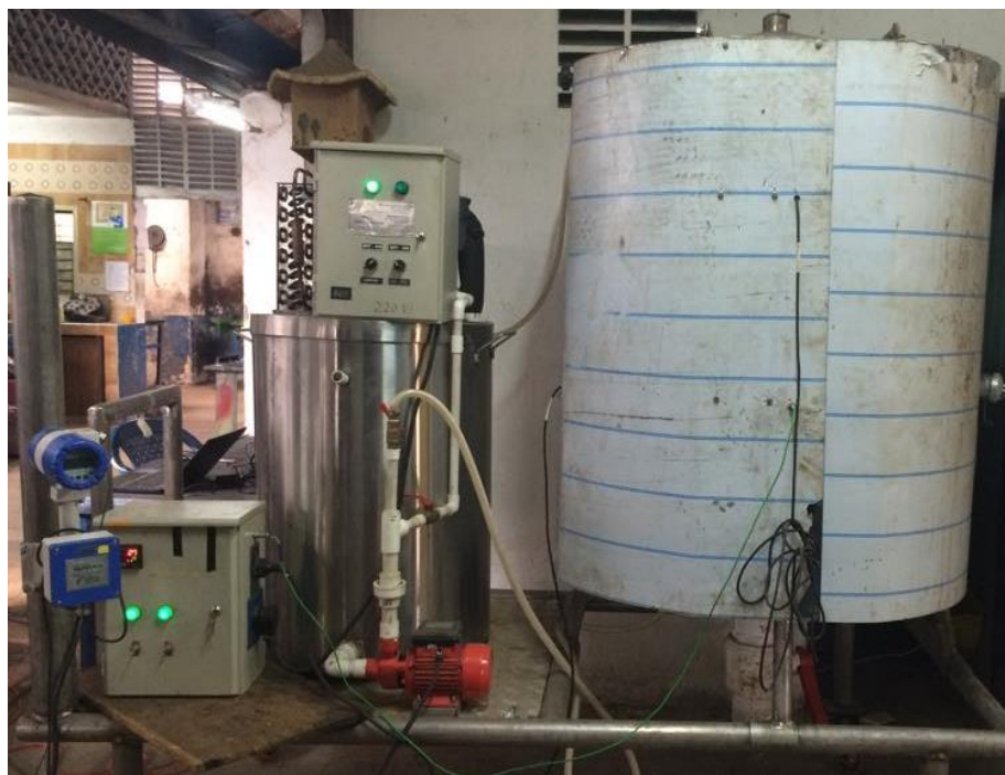
Figura 7-29. Parte frontal del sistema general de control de temperatura y pH para fermentación de café.
