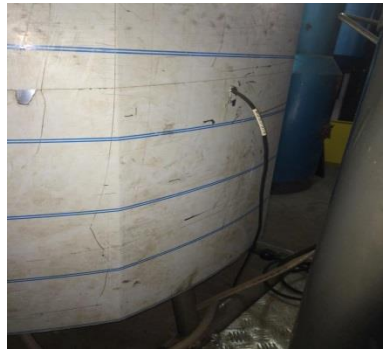
Figura 7-12. Ubicación del sensor de pH en la parte inferior del tanque fermentador.
