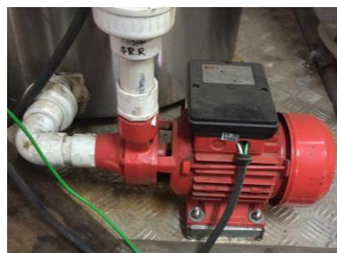
Figura 7-3. Bomba de suministro y retorno del chiller
