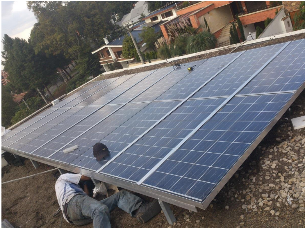
Figura 32. Arreglo 1 de 12 módulos Santa Ana
