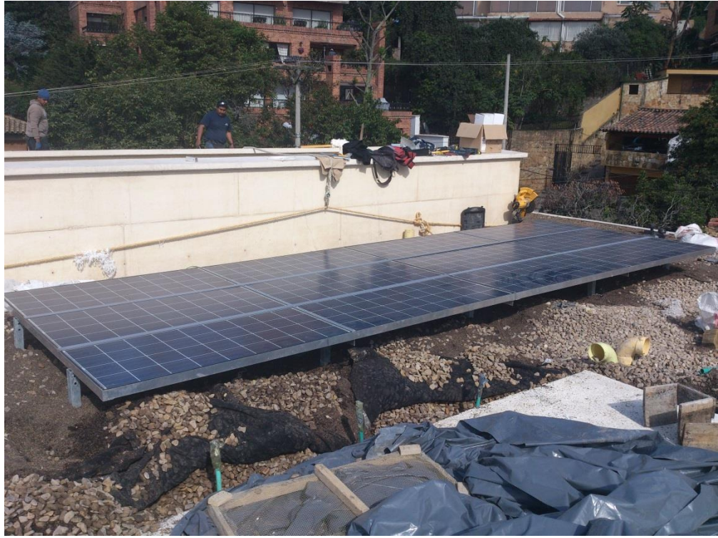
Figura 32. Arreglo 1 de 12 módulos Santa Ana
