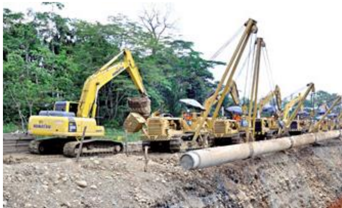
Figura 1 Construcción de oleoductos y gasoductos [3]
