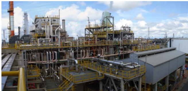
Figura 4 Montaje electromecánico de plantas industriales [6]
