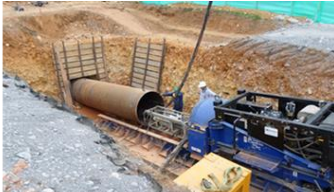
Figura 2 Cruces por perforación horizontal dirigida [4]
