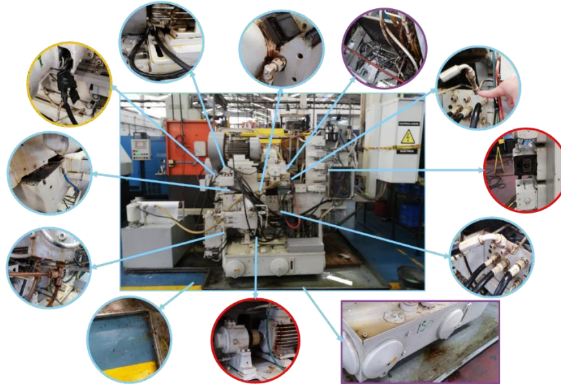
Figura 42: Hallazgos en planta para una de las máquinas
