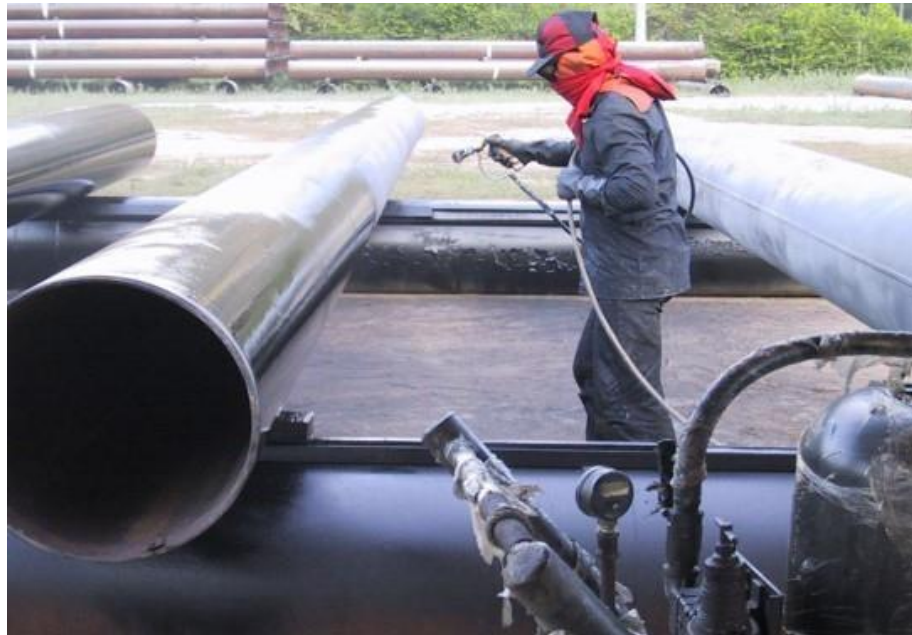
Imagen 6. Aplicación de pintura.
