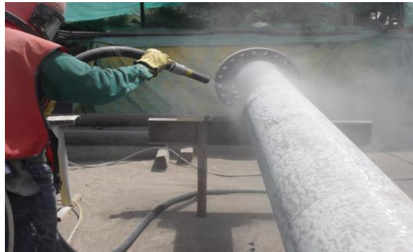
Imagen 4. Aplicado de Sanblasting.
