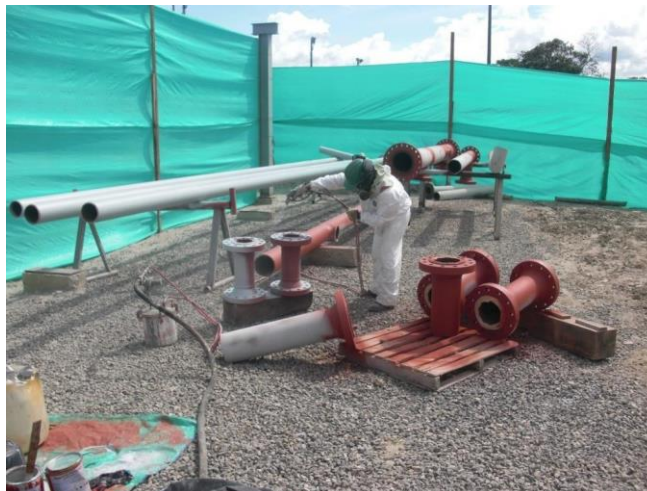
Imagen 5. Aplicación de anticorrosivo.
