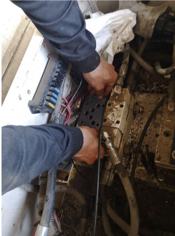
Figura 45 Instalación de la placa.
