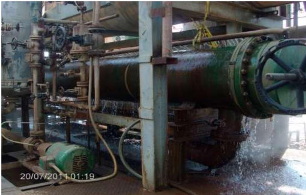
Imagen 3. Intercambiador de calor de MEA.
