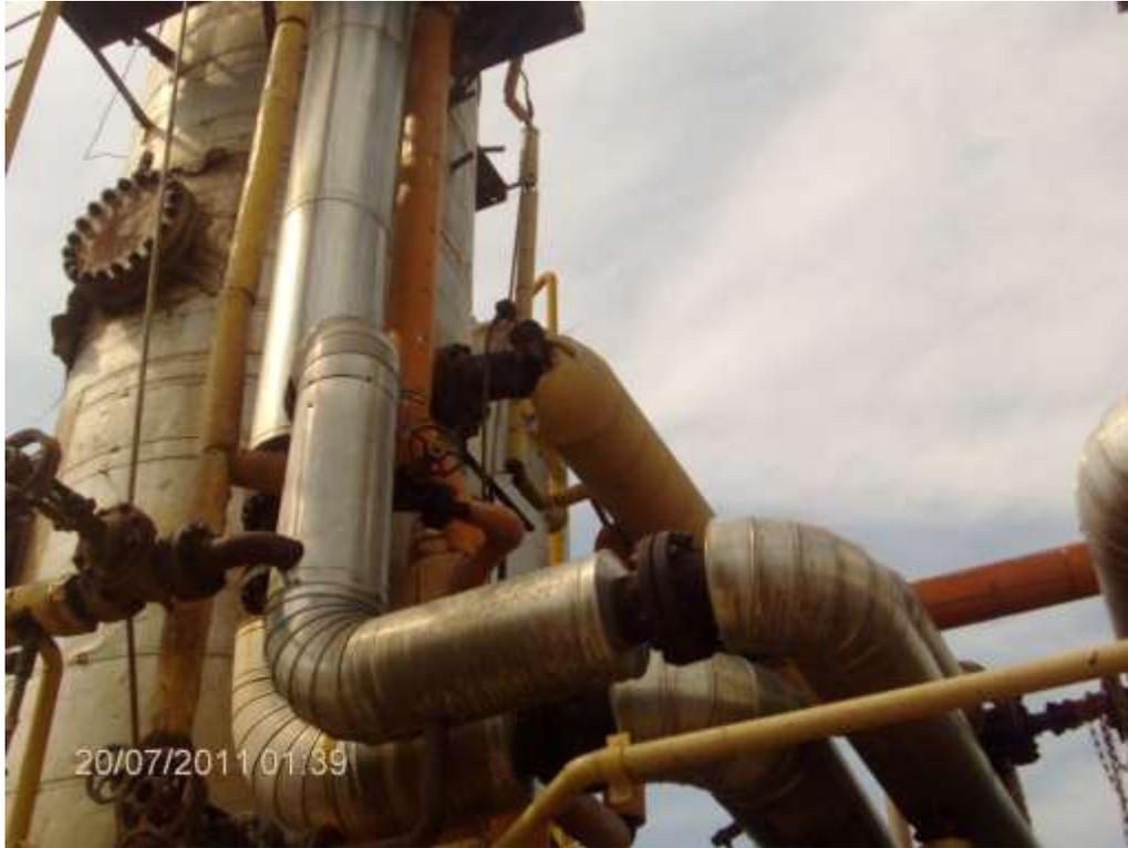
Figura 33. Pre calentador de gas de carga, E-1.
