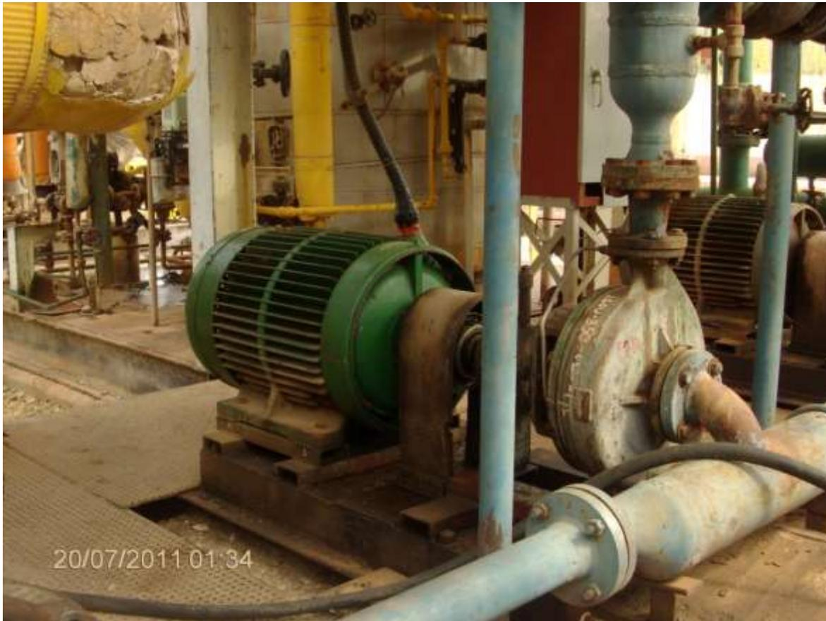
Figura 37. Bombas de condensado.
