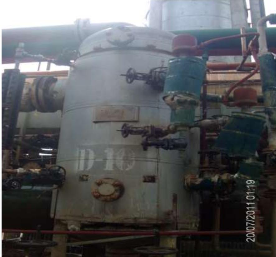
Figura 36. Separador de condensados.
