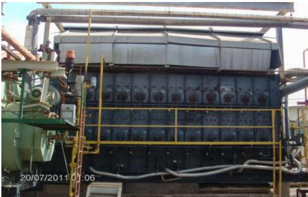
Imagen 10. Parte posterior de caldera de calor residual.
