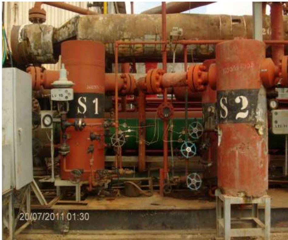
**Imagen 19. Tanques de baja presión**
