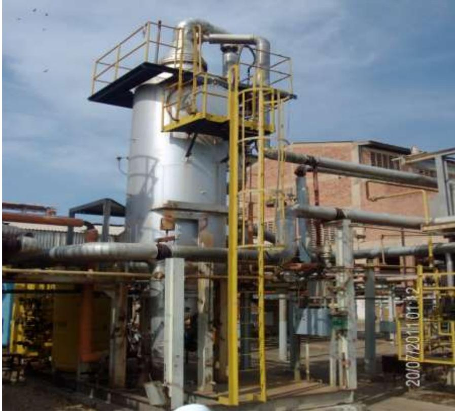
**Imagen 1. Reformador primario.**
