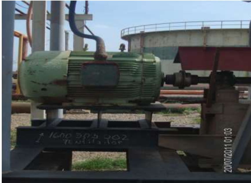
Imagen 18. Ventilador de tiro inducido.
