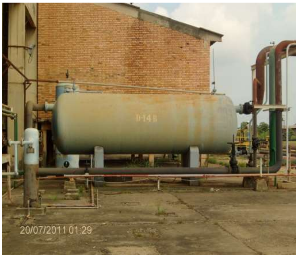
Imagen 15. Tambor separador de condensados.
