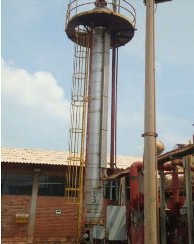
Imagen 22. Convertidor de amoníaco.
