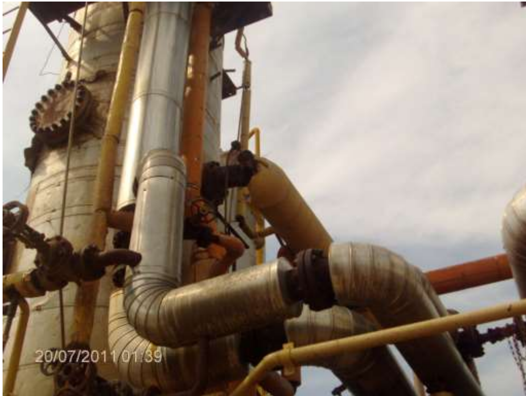
Figura 3. Pre calentador de gas de carga, E-1.
