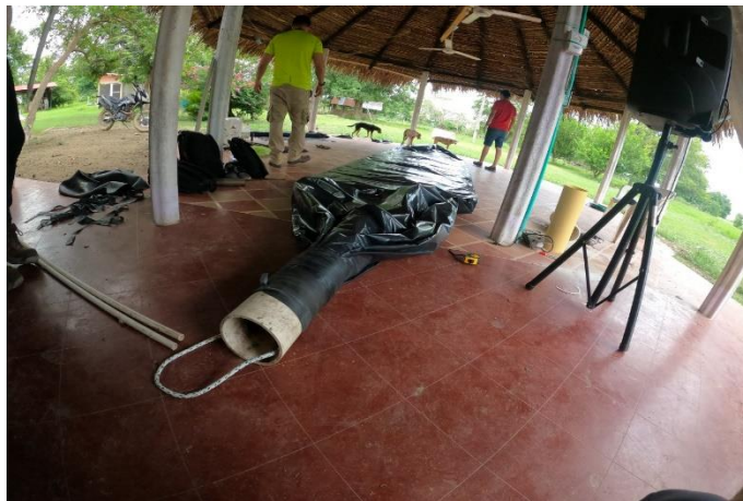
Ilustración 17 Incorporación de la entrada y salida del biodigestor
