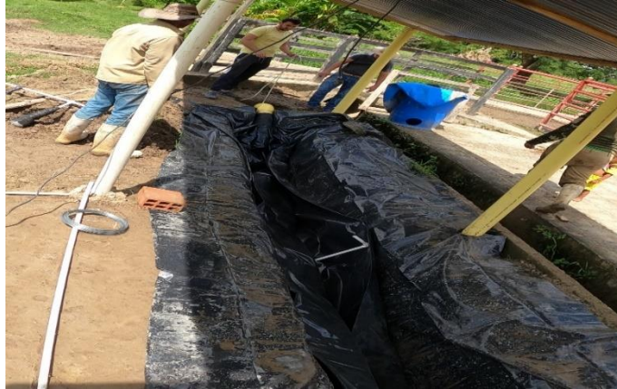
Ilustración 20 Adhesión del polietileno en la zanja e integración del biodigestor
