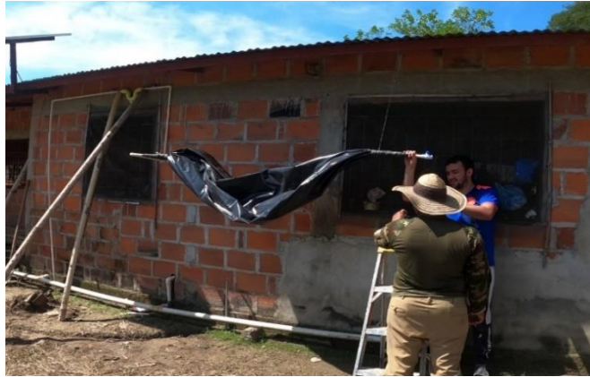
Ilustración 26 Acople del reservorio en el sistema
