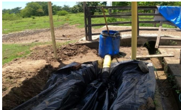
Ilustración 22 Carga y alimentación del biodigestor
