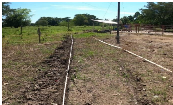
Ilustración 25 Instalación de las tuberías
