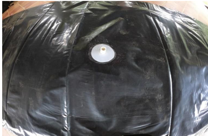
Ilustración 15 Apertura y sellado de la salida de biogás
