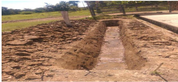
Ilustración 10 Perforación del suelo
