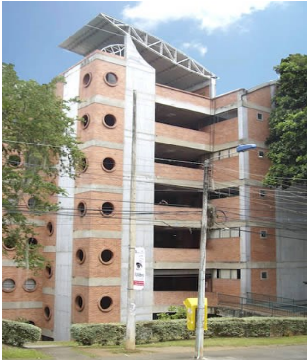
Figura 38. Edificio Ingenierías UNAB
