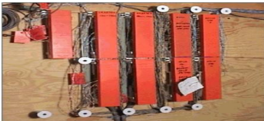
Figura 3. Punto de demarcación
