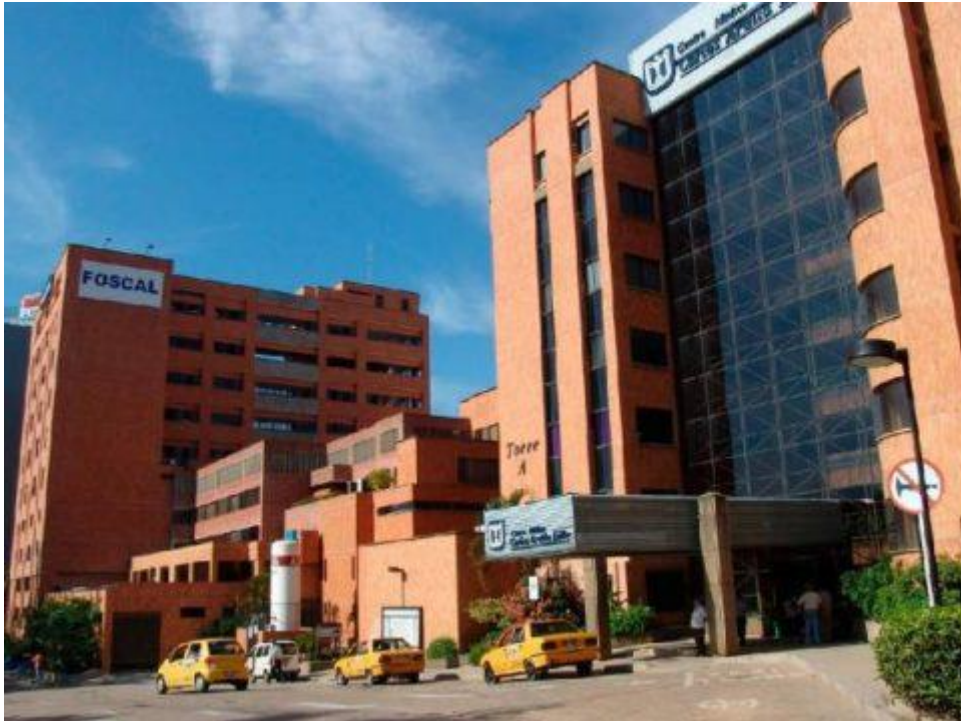
Imagen 1. Infraestructura clínica Foscal
